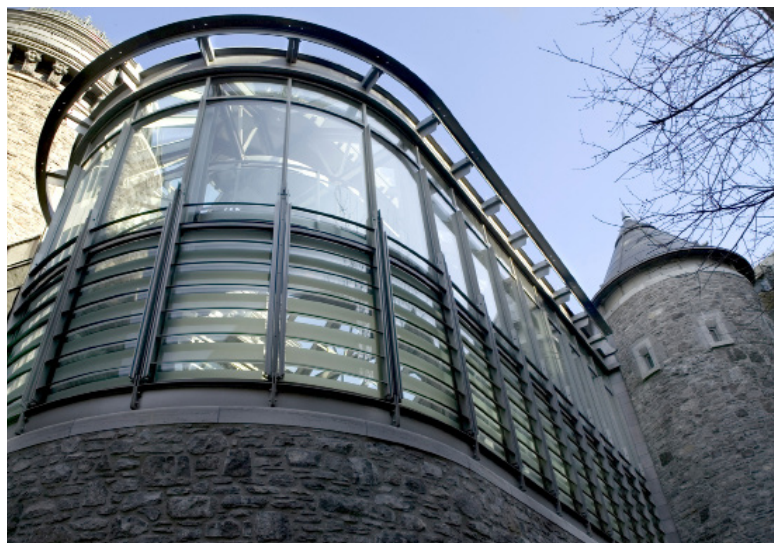
Le 357c, Restauration, réhabilitation et agrandissement, Montréal (QC)
