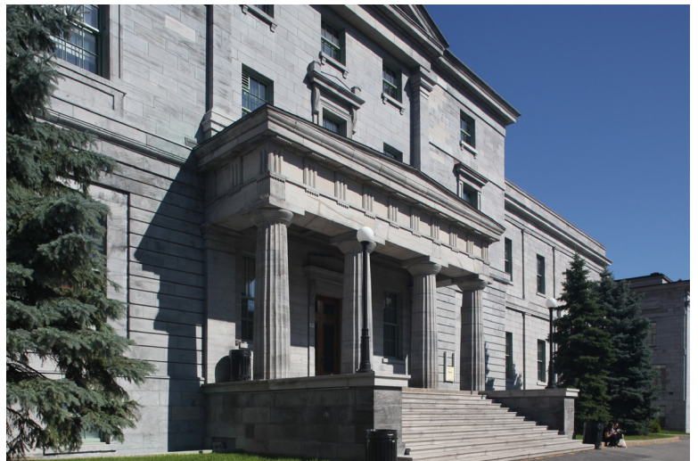
Pavillon des arts - Université McGill, Statbilisation du portique d'entrée, Montréal (QC)
