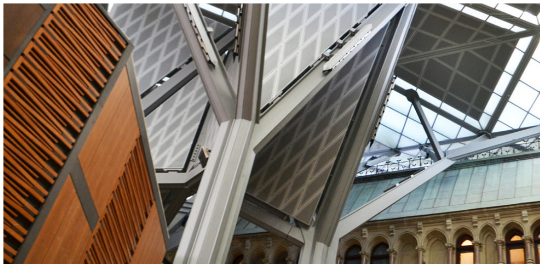
Édifice de l'Ouest, Parlement du Canada, Restauration, réhabilitation et agrandissement, Ottawa (ON)
