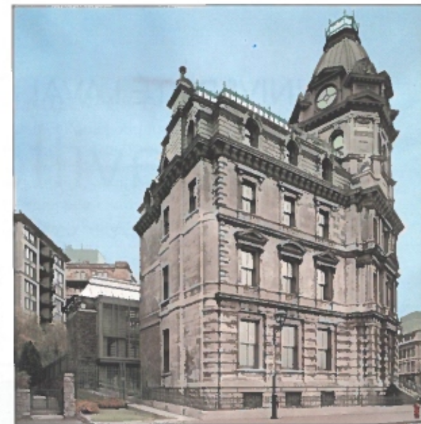
Rue de la Commune Ouest à Montréal, l'ancien édifice des Commissaires du Havre a été réhabilité en club privé, le 357C. Les fenêtres ouvrantes d'origine, en bois, ont été restaurées. Photo: Marc Cramer
