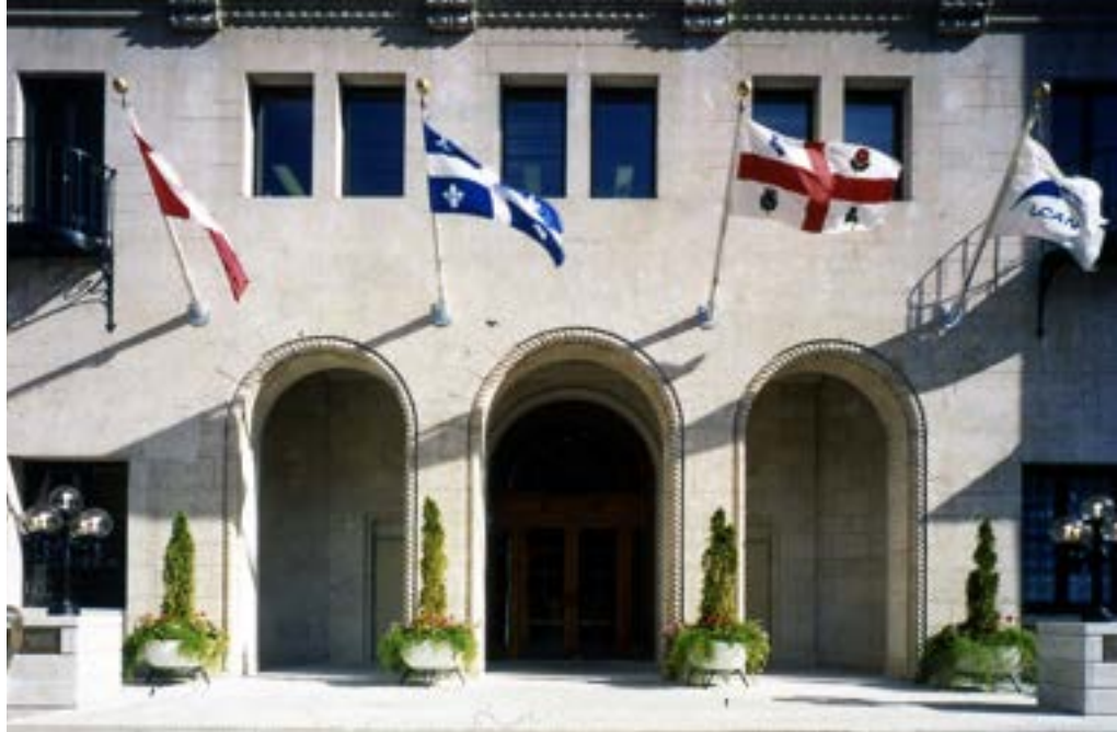
Façade avant réhabilitée de l'hôtel Berkeley, une fois la marquise retirée. Les trois arches ont été ouvertes afin de créer une loggia au rez-de-chaussée et dissimuler les sorties de secours donnant sur la rue Sherbrooke.
